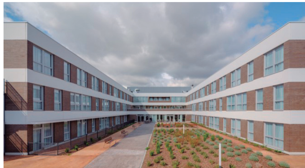
Vitoria es una residencia de 135 camas entregada en 2025, operada por Emeis
