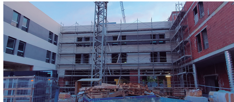
Promoción de una residencia de ancianos en Valencia durante su construcción
